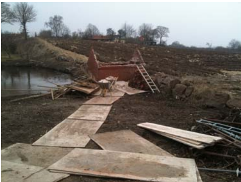
Pumpehus bliver renoveret
