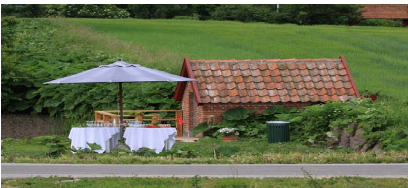
Det færdige nye pumpehus
